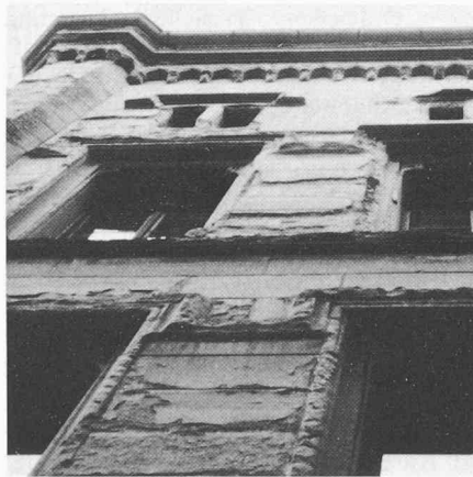
Bild 5a. Ist-Zustand vor Sanierung. Verwitterung
