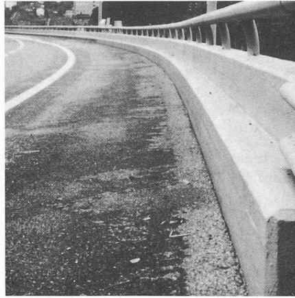
Bild 3b. Schutzanstrich auf Beton
