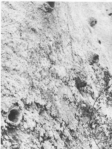
Bild 12. Unansehnliche Spritzbetonoberfläche («Überzähne»)
