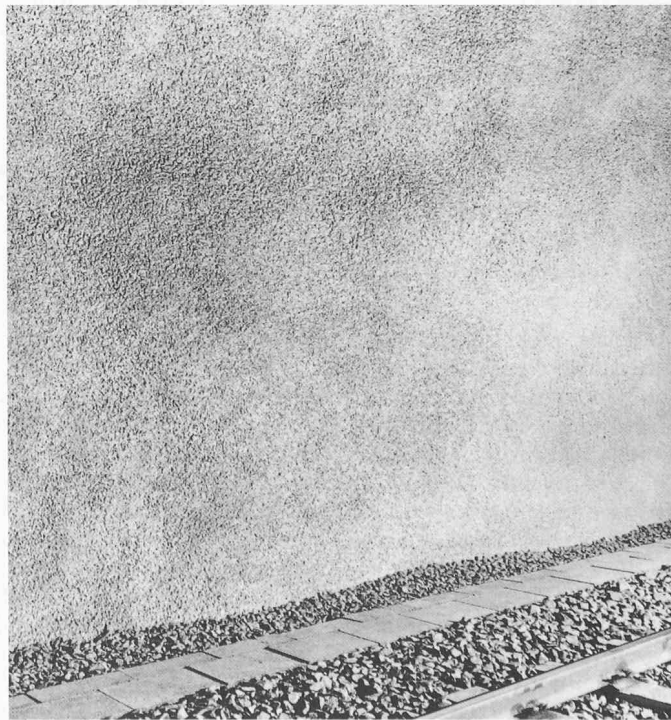
Bild 11. Sorgfältig hergestellte Spritzbetonfläche (Foto: O. Pfeifer, Luzern)
