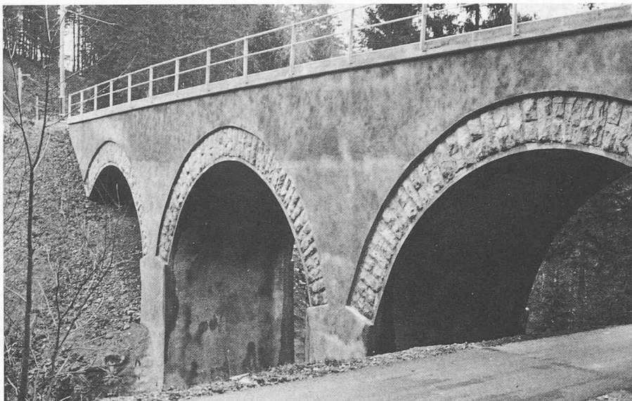
Bild 9. Durch eine verunreinigte Spritzdüse verursachte Fleckung («Leopardenfell»)
