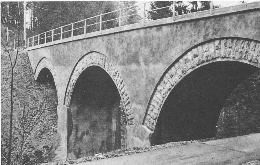
Bild 9. Durch eine verunreinigte Spritzdüse verursachte Fleckung («Leopardenfell»)
