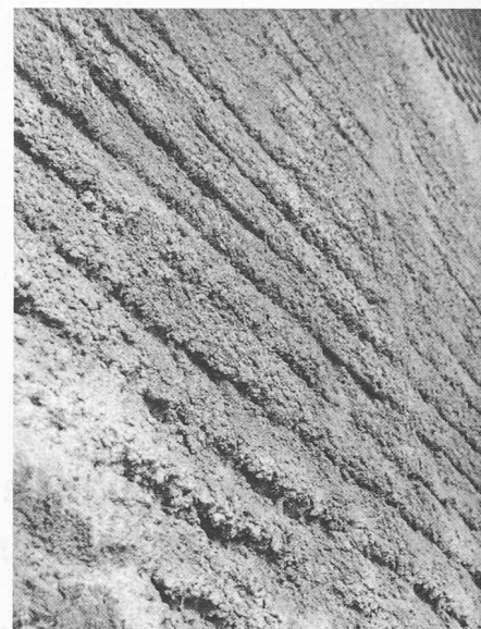
Bild 14. Mit Spritzbeton ungenügend überdeckte Armierungsdrähte
