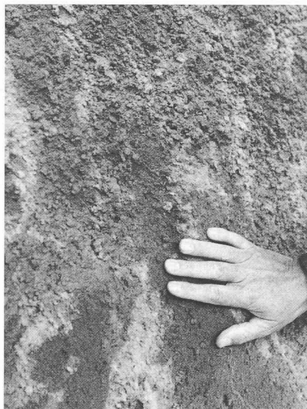
Bild 13. Unregelmässige Spritzbetonoberfläche (schwankende Rauheit)
