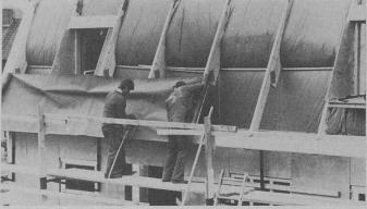
Die leichte Verlegbarkeit der «Underlagstak»-Dachunterspannbahnen von Icopal beruht auf dem geringen Gewicht und den guten mechanischen Eigenschaften des Materials. Die hohe Zugfestigkeit und die ausgezeichnete Reissfestigkeit und Nagelausreissbeständigkeit des bitumenbeschichteten «Typar»-Polypropylen-Spinnvlieses schützen die Dachdecker vor Durchtritt
