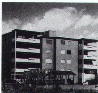
Foto: Peter Weber, BBI Bauberatung und Bauinformation
