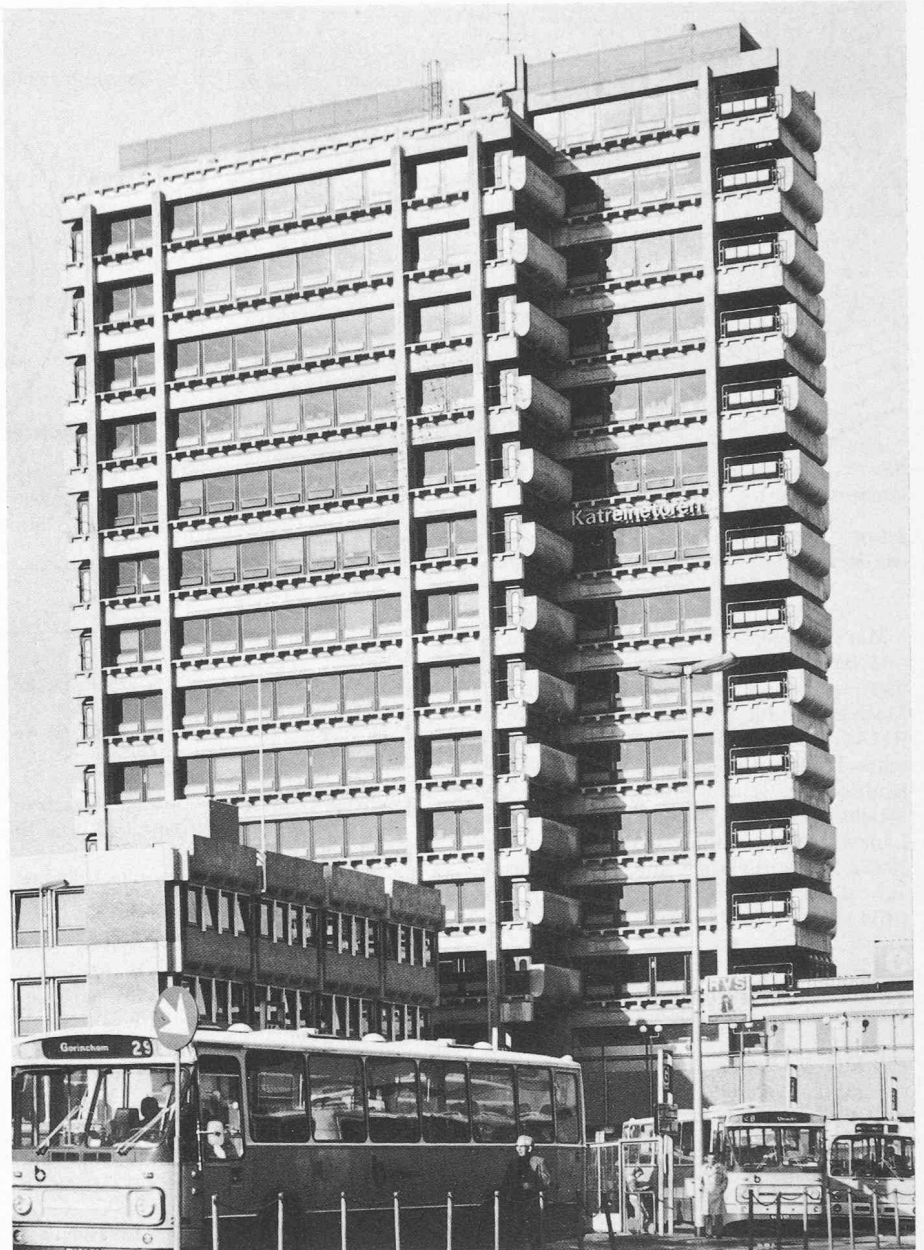
Bild 7. Aus Stahlbetonfertigteilen errichtetes Verwaltungsgebäude der NS mit 14 Stockwerken im Hauptbahnhof von Utrecht – zusammen mit der Überbauung des Bahnhofes erstellt
