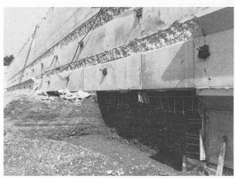
Bild 14. Aushubetappe mit abgespitzten Einfüllkörpern im Hintergrund
