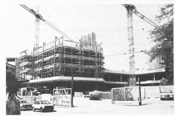
Bild 11. Bürotrakt im Rohbau. Der Liftschacht wurde mit einer Kletterschalung vorgezogen, um Bauzeit zu sparen
