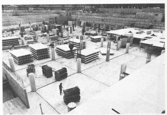
Bild 10. Rasterausschnitt aus dem Flachdeckensystem
