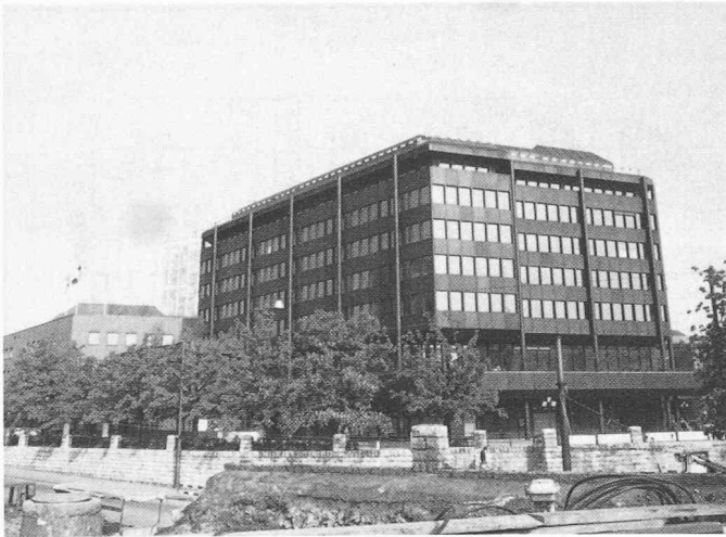
Bild 6. Bürotrakt von Südosten, Ecke Zürcher-/Rudolfstrasse
