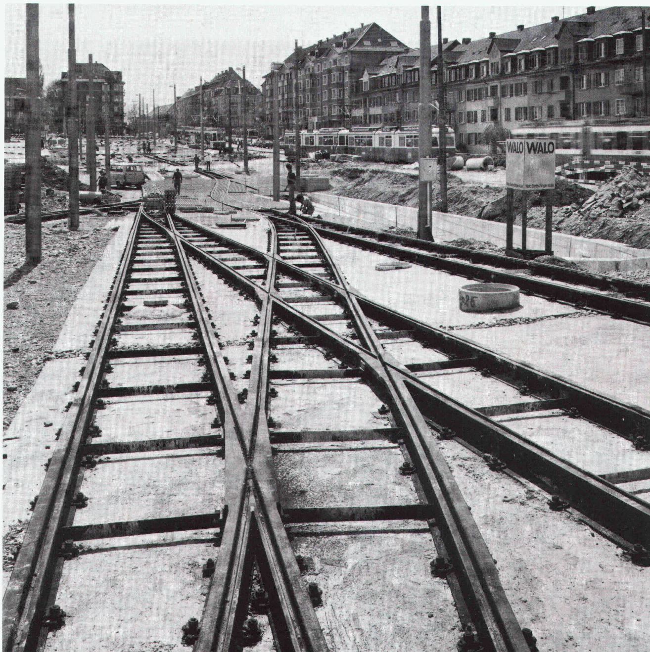
Totalumbau der Geleiseanlage Hirschwiesenstrasse, VBZ, Zürich
