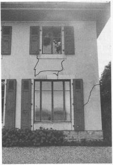
Fig. 3. Fissurations en façade du corps sud
