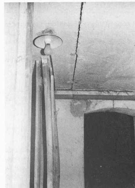
Fig. 4. Déformation des cloisons de séparation et fissuration au plafond d'une des caves
