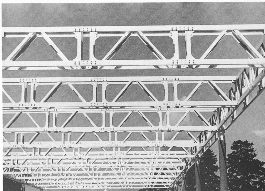
Bild 3. Die Träger des Schulgebäudes während der Montage
