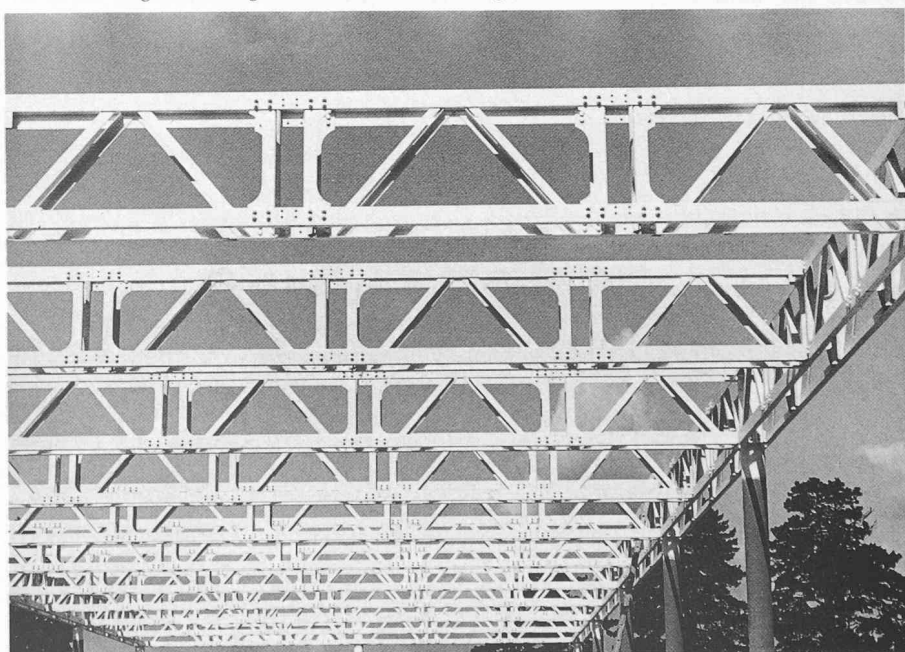
Bild 3. Die Träger des Schulgebäudes während der Montage
