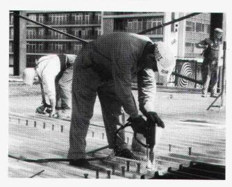
Die Schweißarbeiten werden rationell und wirtschaftlich mit speziellen NELSON-Bolzenschweißgeräten ausgeführt. Sie können vom Anwender selbst oder vom
