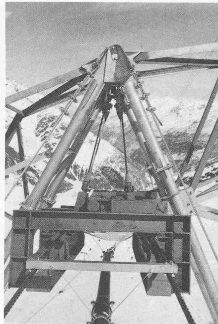
Bild 7. Mittelstütze, Seilsattel
