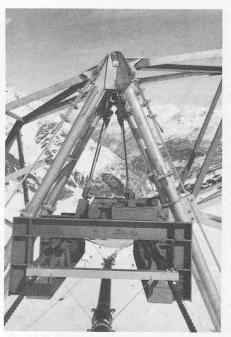
Bild 7. Mittelstütze, Seilsattel
