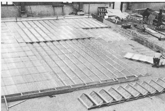
Bild 7. Bewehrte Bodenplatte vor dem Betonieren
