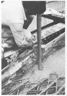
Bild 3. Fliessfähiger Superleichtbeton
