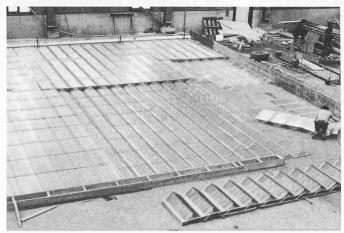
Bild 8. Vorfabriziertes Wohnhaus mit Verbundplatten aus Polyurethan
