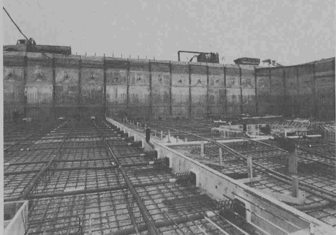
Flughafen Zürich Kloten. Zentrisch vorgespannte Bodenplatte für den Fingerdock des Terminal A. Arbeitsfuge mit BBRV-Rapidverankerungen; die BBRV-Spannkabel können damit nach 3 Tagen 100% vorgespannt werden
