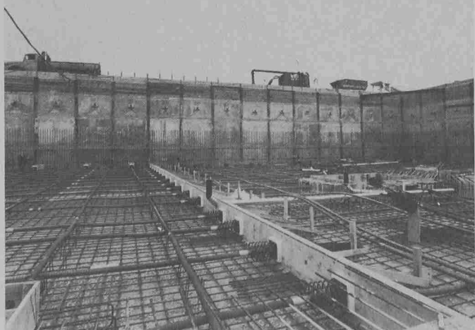
Flughafen Zürich Kloten. Zentrisch vorgespannte Bodenplatte für den Fingertock des Terminal A. Arbeitsfuge mit BBRV-Rapidverankerungen; die BBRV-Spannkabel können damit nach 3 Tagen 100% vorgespannt werden
