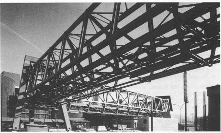
Stahlkonstruktion des Hochkanals. Kanalknick mit dreibeinigem Abstützbock (Photo Hauser, Bild 5 Andelfingen)
