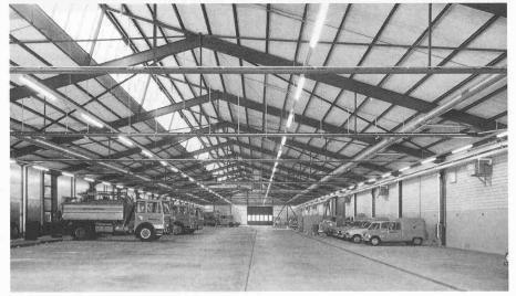
Ortsbetondecken und vorfabrizierten Betonstützen erstellt. Das Gebäude ist nicht klimatisiert und nur dort mit Lüftungen versehen, wo es die Nutzung der Räume erfordert. Für die vertikale Erschliessung sorgen zwei Personenaufzüge im Hochbau und ein Warenaufzug im Flachbau. Die Fassaden des Flachbaus bestehen aus einem inneren, tragenden Betonteil bzw. Ausmauerung, einer äusseren Isolation von 10 cm und den davorgehängten vorfabrizierten Betonelementen von 9,00 m Höhe.
