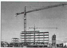
Stahlkonstruktion eines mehrgeschossigen Schulge-
