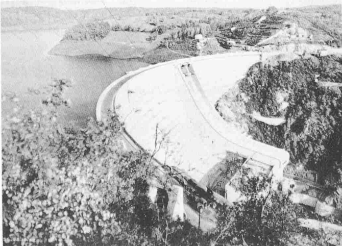
Bild 14. Getreppte Luftseite der Staumauer Bort (Frankreich). Die Treppendienten während des Baues zur Abstützung des damals (1946) noch verwendeten Portalkrangerüsts (Science et Industrie)
