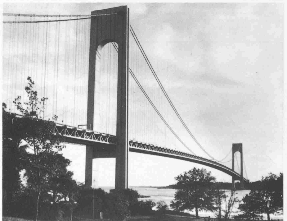
Bild 1. Die Verrazano-Narrows-Brücke verbindet Staten Island mit Brooklyn über die Hafeneinfahrt von New York. Bei der Eröffnung 1964 galt sie als die längste Hängebrücke der Welt. Die freie Spannweite beträgt 1298 Meter
