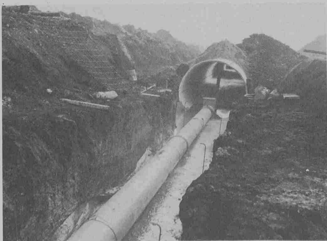
Einbetonierte PVC-Leitung in Armco-Rohr
