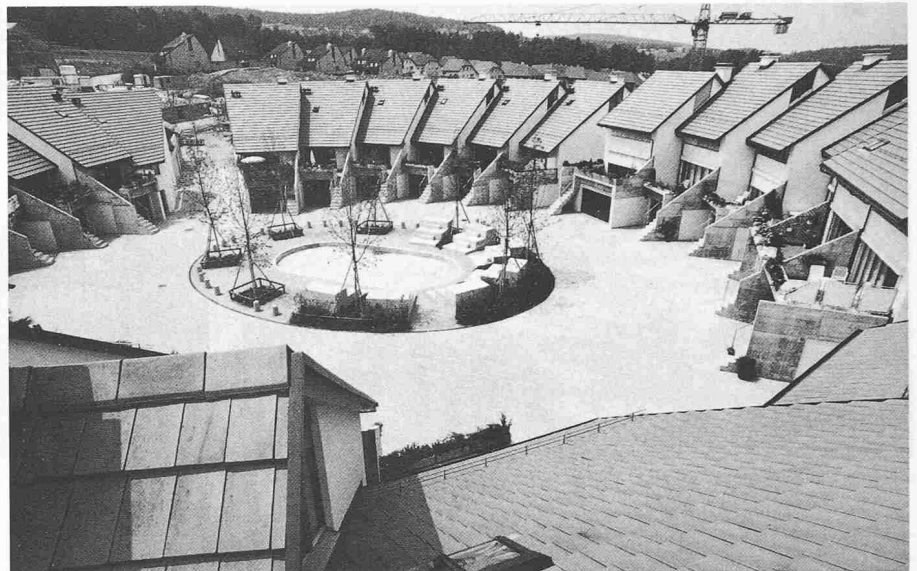
Überbauung Sonnenhof. Hofansicht mit Eingangspartie
