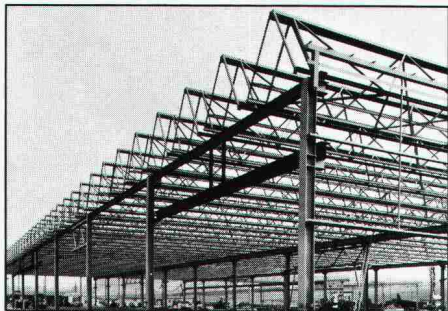
Metallstruktur eines Fabrikgebäudes mit Mini-Sheddach
