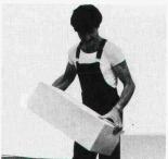
1 Gemauert als monolithische Fassade mit dem k-Wert 0,24W/m2K bei 35 cm Wandstärke. Qualität GL und 5 Gew.-% Feuchtigkeit.
