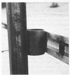
Bild 12. Deformationselemente zwischen Kastenprofil und Pfosten
