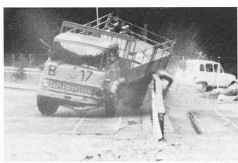
Lastwagenversuch B 17 (5,6 t, 71 km/h, 15°) an der Leitschranke mit Planke Profil A und Handlauf
