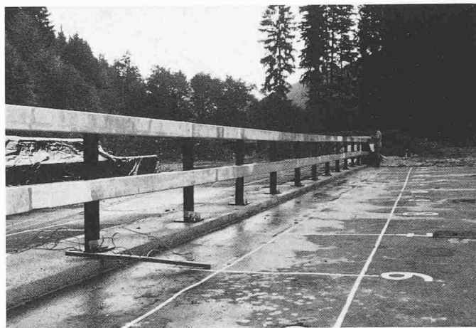
Bild 11. Leitschranke mit 2 Kastenprofilen 130/150 mm auf einer 10 cm hohen Bordüre
