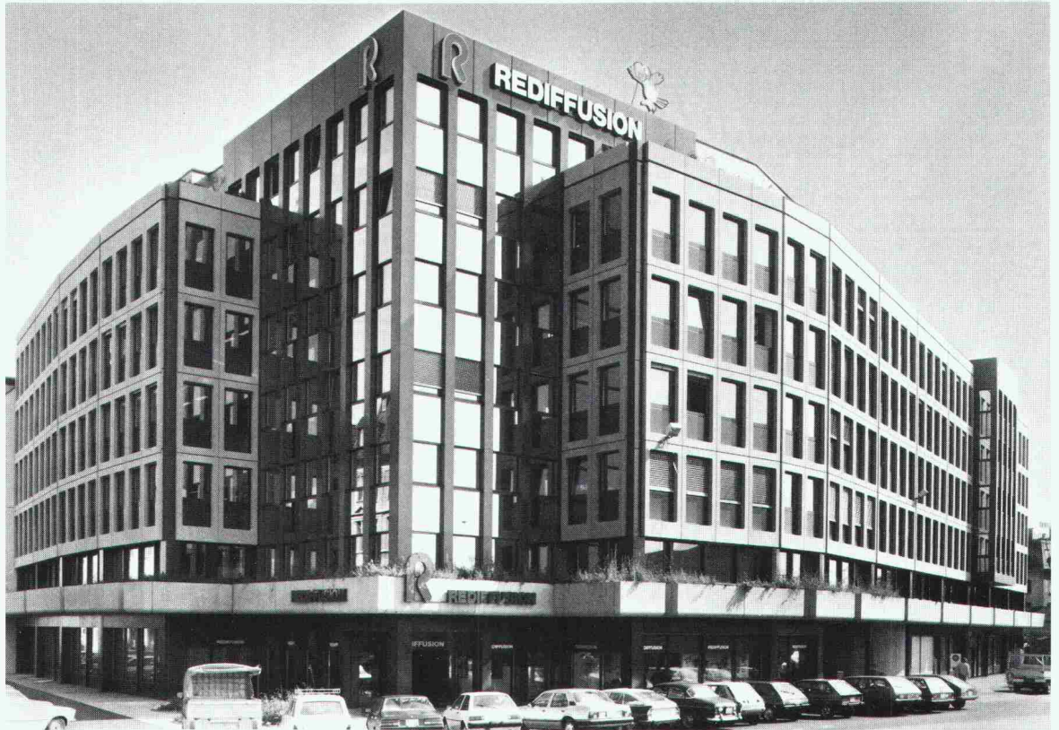
Geschäftshaus Hafner-/Zollstrasse, Zürich. Die bauphysikalisch anspruchsvolle Fassade ist durch die vorgehängten Betonplatten geprägt; diese sind eingefärbt und ihre Sichtflächen sind sandgestrahlt.
