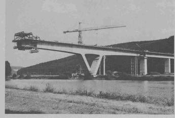
Bild 2. Schalung der V-förmigen Pfeiler
