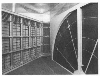
Bild 5. Langzeit-Standfilter reinigen die zuströmende Aussenluft (links). Die Fortluft erwärmt über eine rotierende Speichermasse die Zuluft (rechts)
