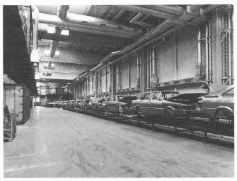
Bild 4. Zuluftkanäle an den Hallenwänden mit Weitwurfgittern und -drallauslässen bringen die frische Luft zugfrei in die Halle
