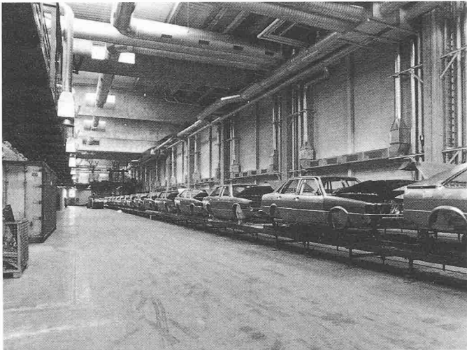
Bild 4. Zuluftkanäle an den Hallenwänden mit Weitwurfgittern und-drallauslässen bringen die frische Luft zugfrei in die Halle
