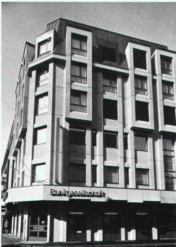
Wohn- und Geschäftshaus Langstrasse, Zürich. Die Eingliederung des Neubaus ins Altstadtbild erfordert eine stark strukturierte Betonfassade.
