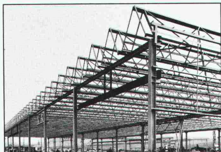
Metallstruktur eines Fabrikgebäudes mit Mini-Sheddach
