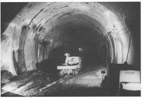
Profilmessgerät in Messposition, im Tunnel installiert auf einem Lastwagen
