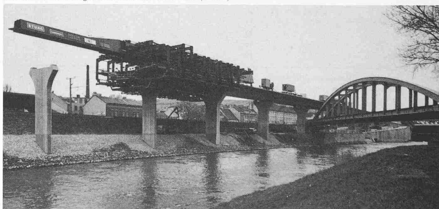
Bild 4. Obenliegender Rüstträger von Bild 3 mit Vorbauschnabel - zum Freihalten des Lichtraumprofils anderer Verkehrswege unter dem neuen Überbau (rechts)
