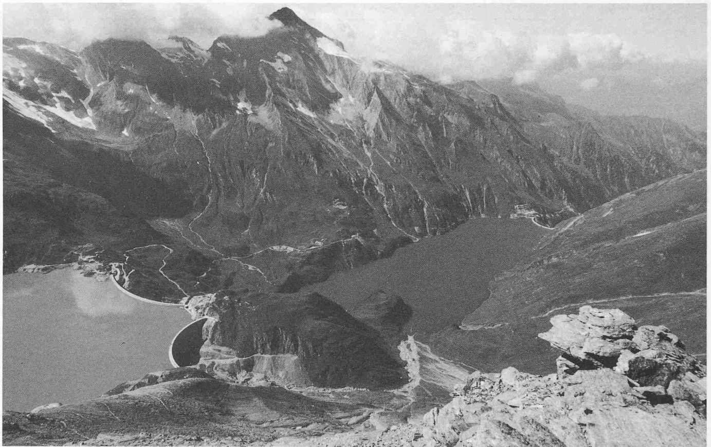
Bild 7. Harmonische Einpassung mehrerer Sperren im Hochgebirge mit Bereicherung durch Wasserflächen (Kaprun)
