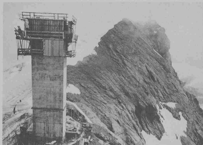
Bau der Fernmelde- und Mehrzweckanlage der PTT auf dem Titlis. Doka-Selbstkletterschalung für den 62 m hohen Liftschacht
