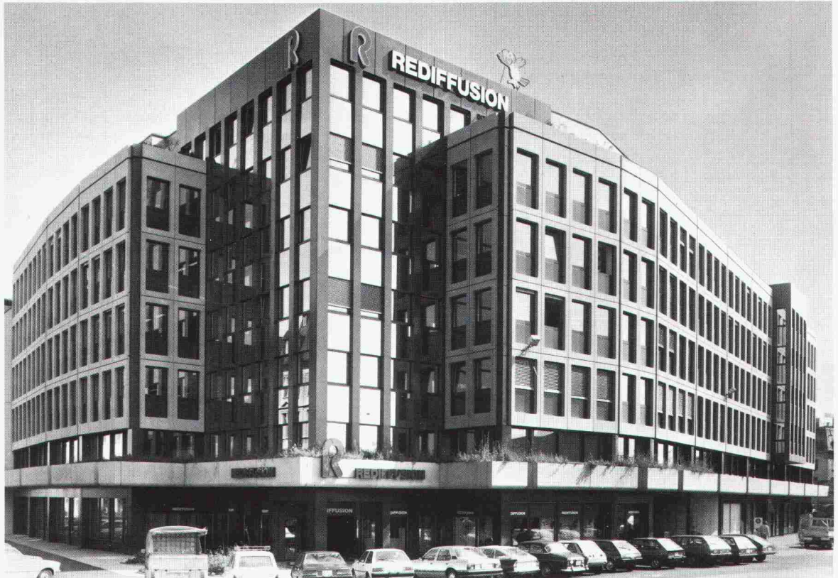
Geschäftshaus Hafner-/Zollstrasse, Zürich. Die bauphysikalisch anspruchsvolle Fassade ist durch die vorgehängten Betonplatten geprägt; diese sind eingefärbt und ihre Sichtflächen sind sandgestrahlt.
