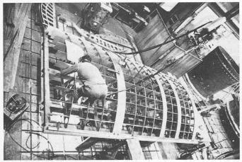
Bild 2. Montage der Blechrahmen auf dem Grundgerüst
