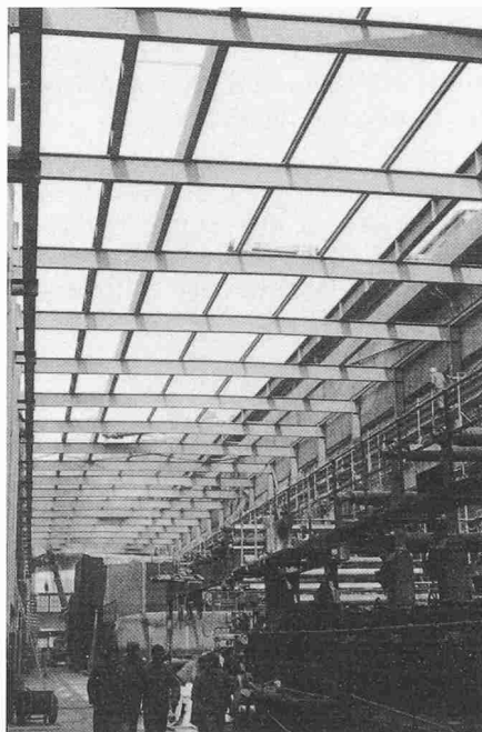
Bild 3. Ende Februar 1983. Stahlbaukonstruktion fertig montiert, bereit für die Dacheindeckung und die Montage der Oberlichter
