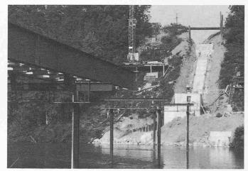
Bild 8. Bau des Rohrleitungskanals mit Brückenwiderlager in der steilen Böschung am rechten Ufer
