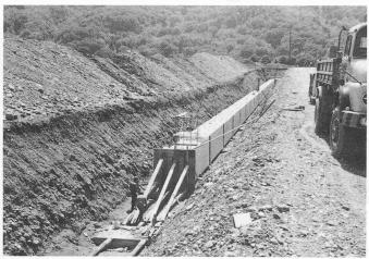
Bau des Abwasserkanals auf der Ebene zwischen Limmat und Kirchdorf. Fertigelemente von 8 m Länge und 22 t Gewicht
