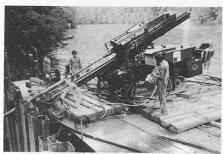
Bild 9. Bohrarbeiten für die Anker ab schwimmender Plattform
