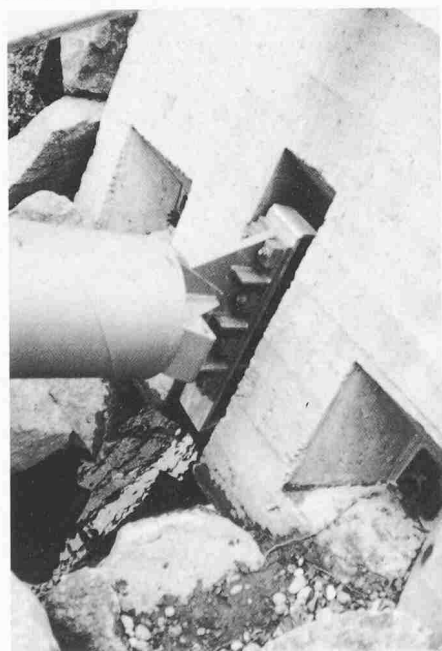
Bild 5. Schrägstützenfundament mit Stützegelelenk. Links und rechts davon die Ankerköpfe der fertig versetzten Anker
