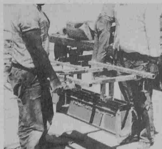
2 Mann tragen Polydrain mit Versetzeinrichtung
