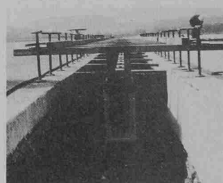
Rinne versetzt, vor dem Betonieren
