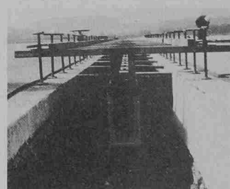
Rinne versetzt, vor dem Betonieren
