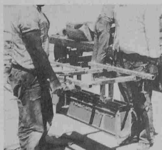
2 Mann tragen Polydrain mit Versetzeinrichtung
