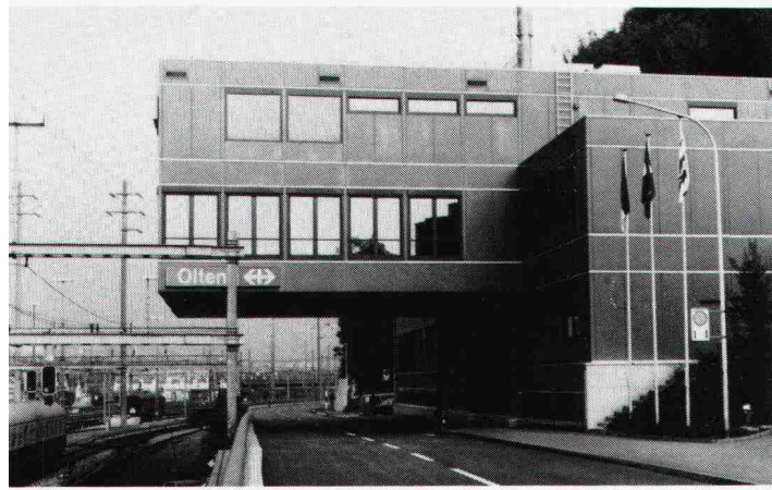
Neues Stellwerk Bahnhof SBB, Olten, Fahrbahnisolierung
