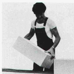
1 Gemauert als monolithisches, homogenes Fassadenmauerwerk mit dem k-Wert  $0.24 \text{ W/m}^2\text{K}$  bei 35 cm Wandstärke, Qualität GL und 5 Gew.-% = Feuchtigkeit.
