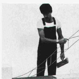
3 Verputzt mit dem SIPOREX-Grund- und Deckputz LAMIT = schlagegendicht und atmungsaktiv.
