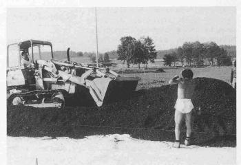
Bild 3. Verteilen und Planieren der zementstabilisierten Kehrichtschlacke auf der Baustelle. Die Verarbeitung kann auch mit einem Fertiger erfolgen
