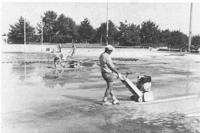
Bild 2. Untergrundbehandlung durch Überfräsen des Ortsbetons mit von-Arx-Aufrauhergerät. Ausgealisieren von ausgespitzten Stellen. Kontergefälle und Vertiefungen mit Giessmörtel aufgiessen, Quarzsand einstreuen
