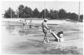
Bild 2. Untergrundbehandlung durch Überfräsen des Ortsbetons mit von-Arx-Aufrauhgerät. Ausegalisieren von ausgespitzten Stellen. Kontergefälle und Vertiefungen mit Giessmörtel aufgiessen, Quarzsand einstreuen
