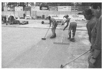
Bild 3. Giessmörtel (1,2 mm) wird mit gezahnter Gummirakel aufgetragen und verteilt. Eingeschlossene Luft wird mit einer Stachelwalze ausgetrieben und die Oberfläche ausegalisiert. Im Hintergrund Teil der Mischstation: Mörtelaufbereitung mit Beba-Mischer
