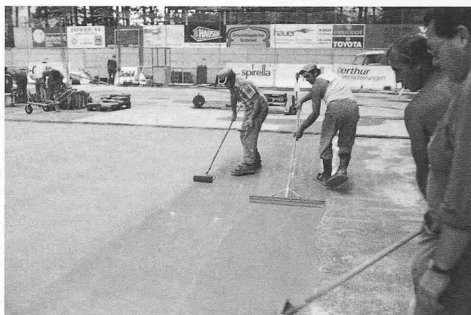
Bild 3. Giessmörtel (1,2 mm) wird mit gezahnter Gummirakel aufgetragen und verteilt. Eingeschlossene Luft wird mit einer Stachelwalze ausgetrieben und die Oberfläche ausgealisiert. Im Hintergrund Teil der Mischstation: Mörtelaufbereitung mit Beba-Mischer
