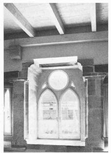
Direktorenwohnung Refektorium: alt: gotisches Mittelfenster, Pfeiler und Wandkonsole; neu: Fensterflügel aus Profileisen, Holzbalkendecke auf Streifbalken
