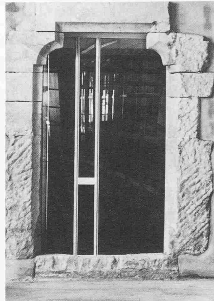
Foyer; alt: Pforte in den Kreuzgang; neu: Verglasung mit Profileisensprossen
