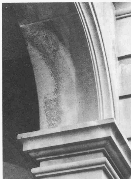
Bild 3. Detail eines Bogenansatzes mit Salzkru- sten und -ausblühungen. Die rechte Pfeilerkante wird vom Regen und oberflächlich abfliessendem Sickerwasser benetzt. Links davon zonare Anreicherung von Gipsausblühungen (heller Striemen Mitte Bogenlaibung) und Magnesiumformiat-Krusten (entlang linker Kante), wo der Stein intensiv absan- det
