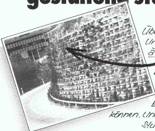
Überall, wo ein steiler Abhang Unterstützung braucht und erst noch ästhetisch aussehen soll, ist Murflex® mehr als am Platz. Die optimal begrünbare Raumgitter-Konstruktion, mit welcher – flexibel – entsprechend den örtlichen Gegebenheiten auch Nischen, Abstrebungen und Ecken ausgebildet werden können. Und – die in Notfällen innerst Stunden ab Lager lieferbar ist.
