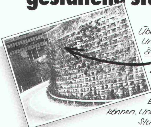
Überall, wo ein steiler Abhang Unterstützung braucht und erst noch ästhetisch aussehen soll, ist Murflex® mehr als am Platz. Die optimal begrünbare Raumgitter-Konstruktion, mit welcher – flexibel – entsprechend den örtlichen Gegebenheiten auch Nischen, Abtreppungen und Ecken ausgebildet werden können. Und – die in Notfällen innerhalb von Minuten ab Lager lieferbar ist.
