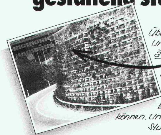
Überall, wo ein steiler Abhang Unterstützung braucht und erst noch ästhetisch aussiehen soll, ist Murflex® mehr als am Platz. Die optimal begrünbare Raumgitter-Konstruktion, mit welcher – flexibel – entsprechend den örtlichen Gegebenheiten auch Nischen, Abtreppungen und Ecken ausgebildet werden können. Und – die in Notfällen innerhalb von Stunden ab Lager lieferbar ist.
