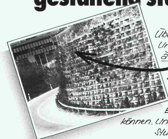
Überall, wo ein steiler Abhang Unterstützung braucht und erst noch ästhetisch aussehen soll, ist Murflex® mehr als am Platz. Die optimal begrünbare Raumgitter-Konstruktion, mit welcher – flexibel – entsprechend den örtlichen Gegebenheiten auch Nischen, Abtreppungen und Ecken ausgebildet werden können. Und – die in Notfällen innerst Stunden ab Lager lieferbar ist.
