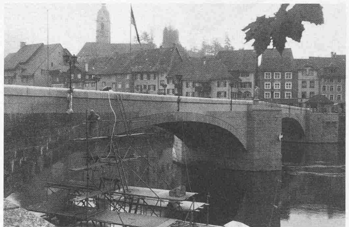
Bild 12. Reinigen der alten Aussenflächen
