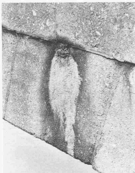
Bild 5. Wasseraustritt und vorgeschobene Stirnmauer, vor der Sanierung
