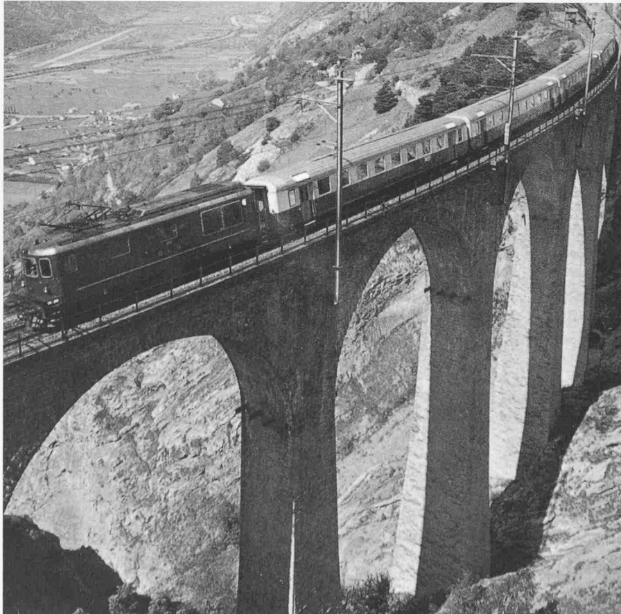
Bild 1. BLS-Luogelkinviadukt mit Rhonetal bei Hohtenn
