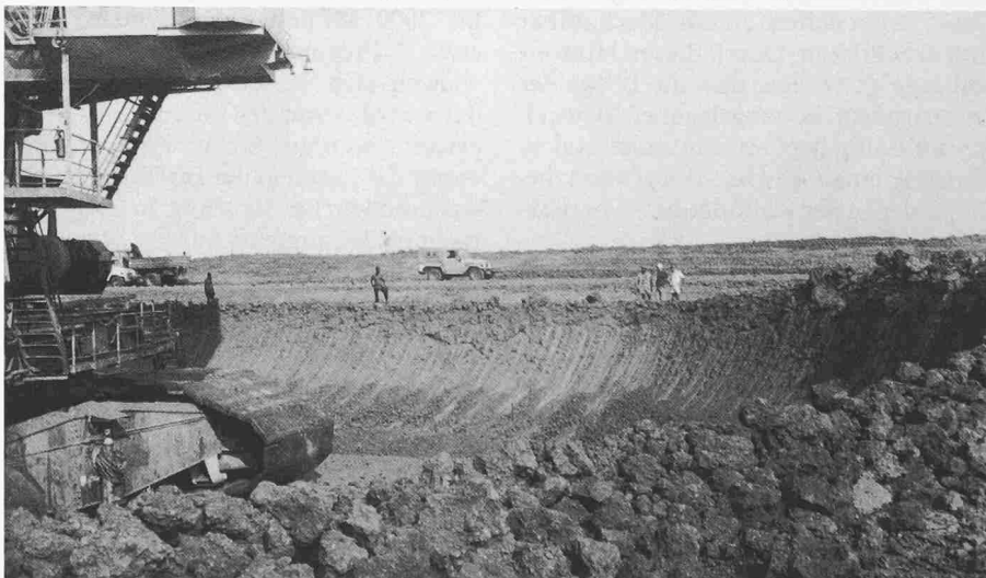
Seitliche Aushubfläche im Kanal. Im Schnitt erscheint (hell) der «cotton soil», darunter (dunkel) der dunkle Mergel. Im Vordergrund liegt der von der Aushubstirne vom Radbagger aufgeworfene Boden. Die seitlichen Aushubflächen werden durch Schaufelbagger auf die bestimmte Böschung abgeschrägt
