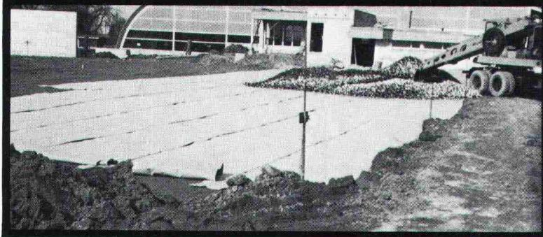
TREVIRA-spunbond wirkt als Trennschicht zwischen Untergrund und Strassenoberbau, als Filter bei Drainagen, Dammschüttungen und Böschungen.
